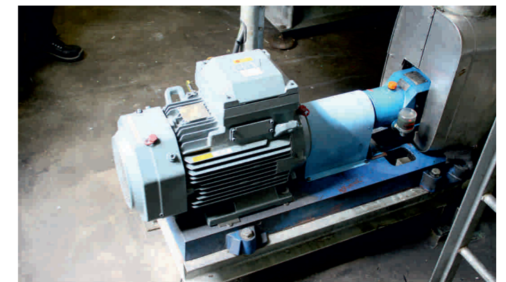
Baureihe CNH-B50-200, Förderdaten 60 m 3 /h, Medium Glykol/Wasser, Prozess Kühlsystem
